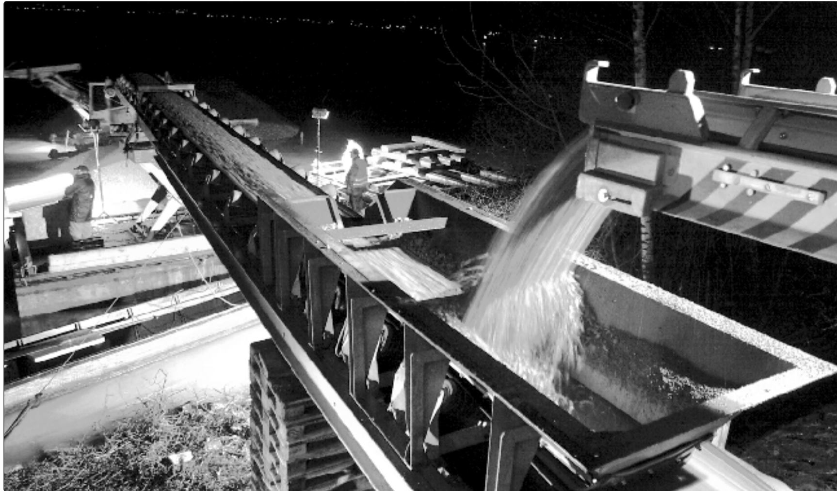
Kies wird vom Güterwaggon über ein Förderband in den See transportiert; ein Bagger sorgt dafür, dass er gleichmässig verteilt wird. Reto Schneider
