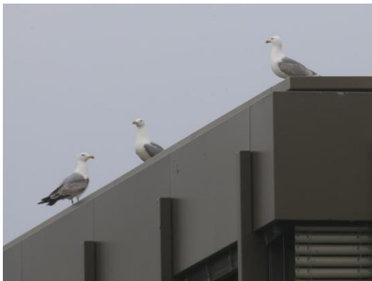
Nester jeweils an den Ecken des Daches
