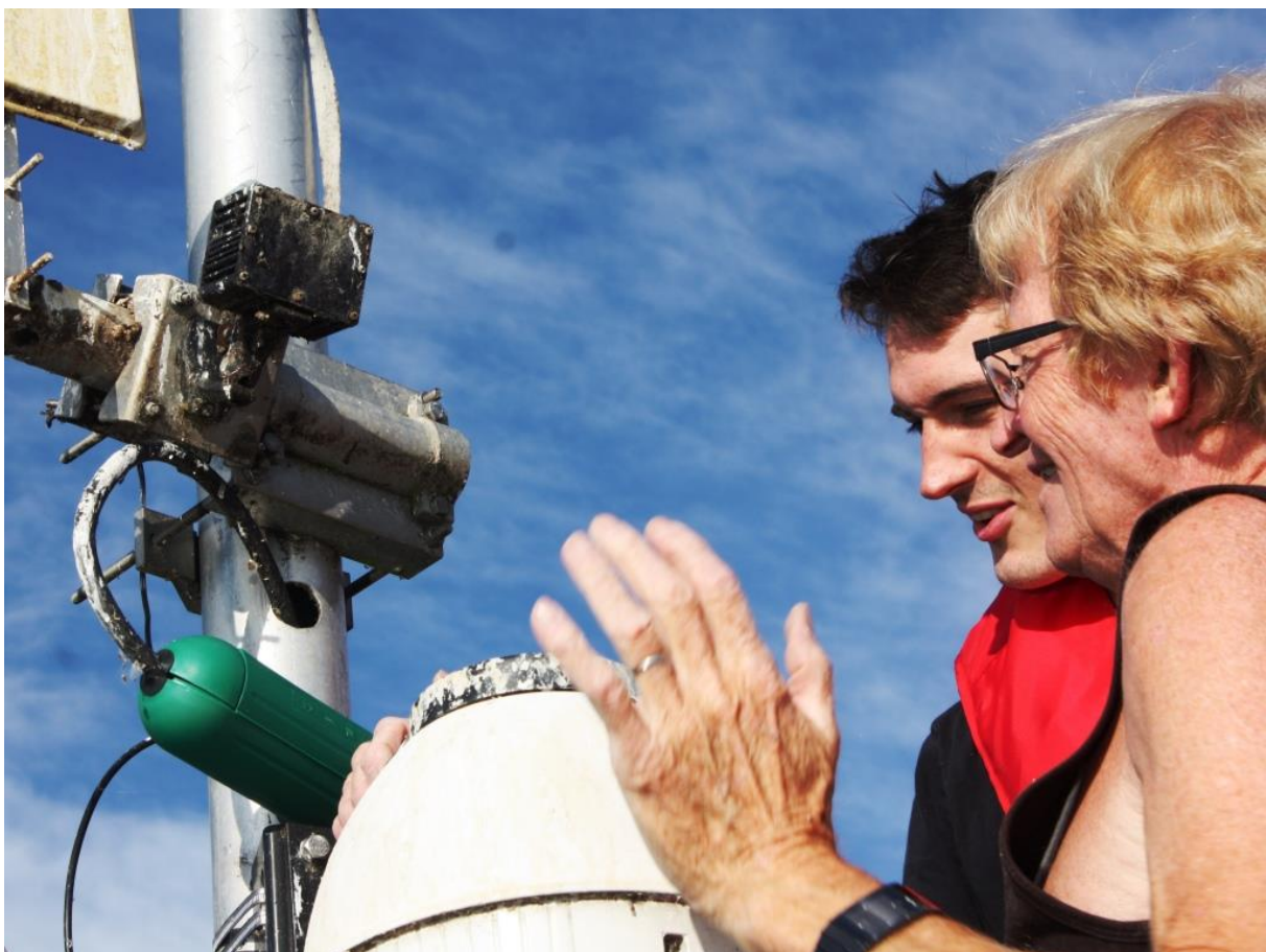
Überprüfung und Erneuerung von Isolationen an der Kamera auf der Kiesinsel am 28. Juli 2016. Patrick Eichler und Walter Schetz.
